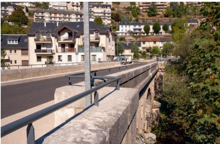
Une lisse a été posée sur le parapet du pont neuf afin de mettre la hauteur de celui-ci aux normes de sécurité. Elle a été réalisée en accord avec l'architecte des Bâtiments de France. Le financement de cette réalisation a été assuré à hauteur de 25 % par la commune, 25 % par l'Agglo, et 50 % par le département.
