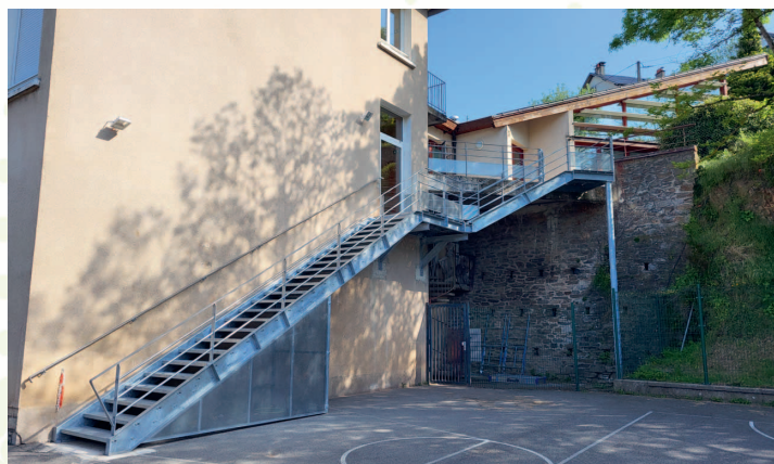
Accès cantine direct depuis la cour.
