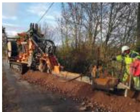
ENEDIS procède à l'enfouissement des lignes électriques sur la route de Babissal, ainsi que sur Combelles et Randeynes. Ces travaux permettront la dépose de 2166 mètres de lignes aériennes vétustes, de 30 poteaux dans des zones boisées et de 2 postes de transformation sur poteaux.
