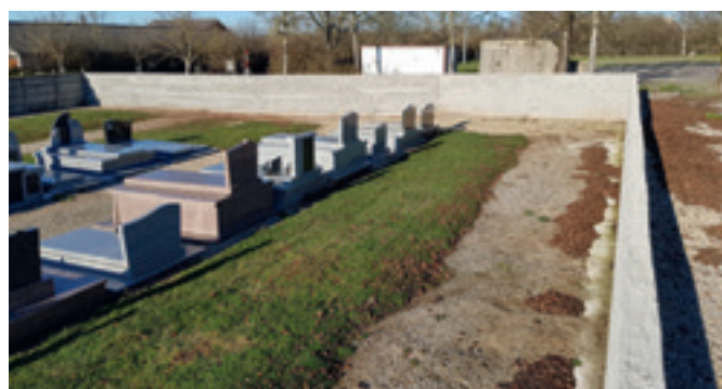
Le mur d'enceinte du cimetière bâti par nos services techniques.
