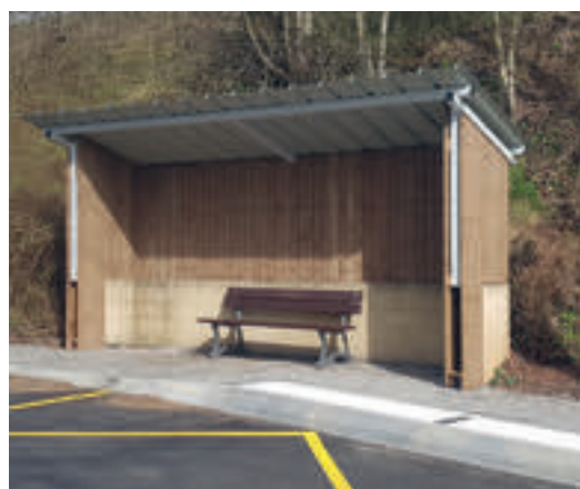
La couverture de l'abribus Avenue du Vivier réalisée par nos services techniques.
