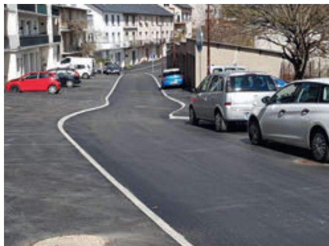
La réfection du réseau d'assainissement et la restructuration de la rue A. Palous sont terminées. Il en est de même pour les travaux d'assainissement Avenue de Millau et Avenue des Arcades.
