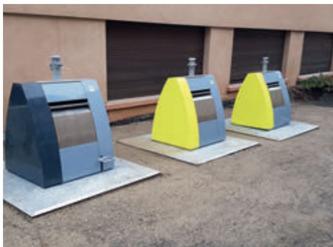
Les conteneurs de déchets sont installés rue Antoine Palous, Rue de la Briane et Avenue Jean Amans Biron (terrasses de Puech Camp).
